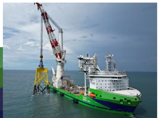
圖 8 「環海翡翠輪」中能風場水下基礎吊裝作業
