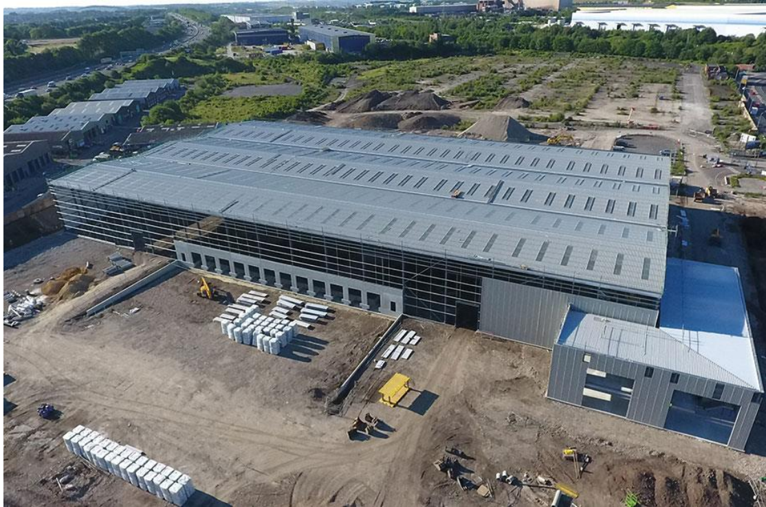
位於謝菲爾德的 ITM Power 正在建造一家工廠，該工廠將生產大型電解槽
