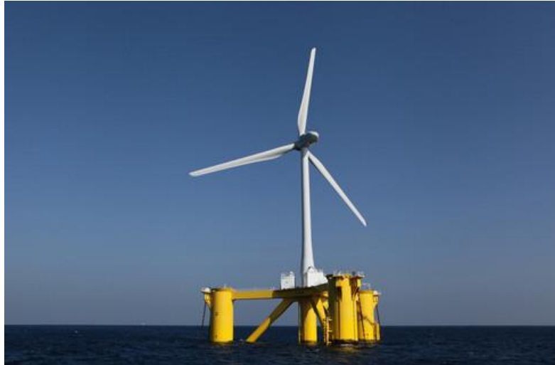
圖 3 福島縣浮動式海上風力發電
