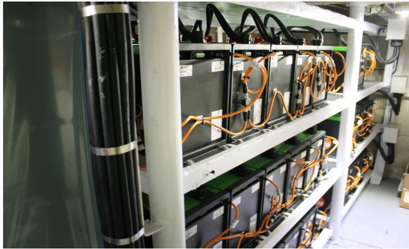
圖五 船舶用鋰電池系統，容量達 100kWh
