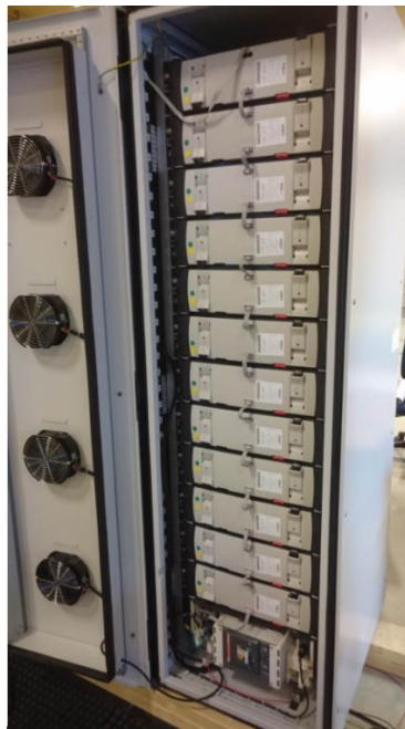
圖五、Saft Seanergy 48 電池系統機櫃箱
